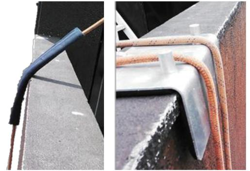
切断防止措置の例 (置き型養生) ▲
