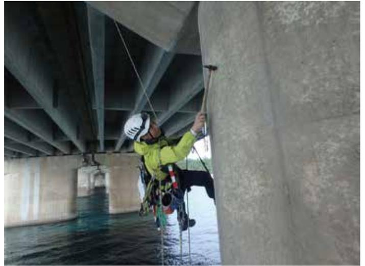
3 - 10 物理探査（コア採取、はつり調査、中性化試験、磁粉探傷）
