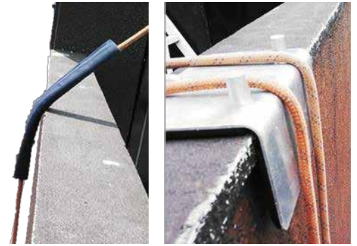
切断防止措置の例 (置き型養生) ▲
