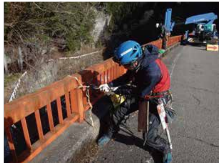
写真 1 - 5 構造物での仮荷重テスト
