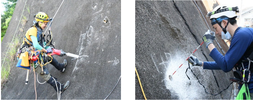
図 2.4 ロープアクセスによるコア抜き実施例 ((株) きいすとん HP より引用)
