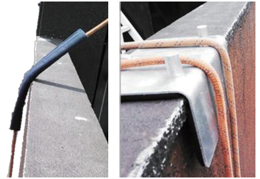
切断防止措置の例 (置き型養生) ▲
